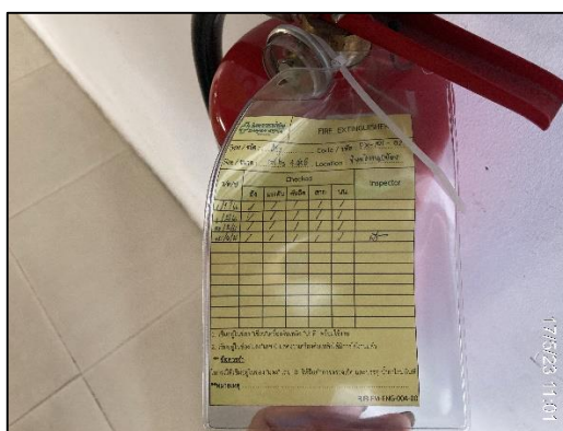
ภาพที่ 41 ตรวจสอบระบบป้องกันและเตือนอัคคีภัย
