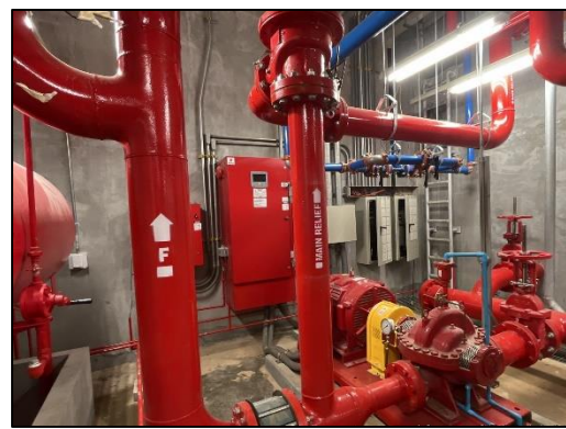
ภาพที่ 32 เครื่องสูบน้ำดับเพลิง
